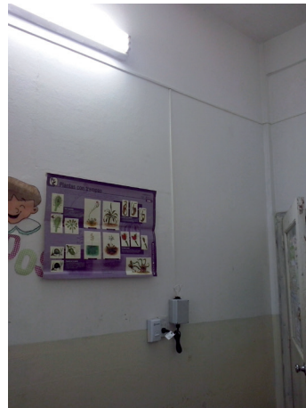
Instalación del LM (amplificador y lazo)
